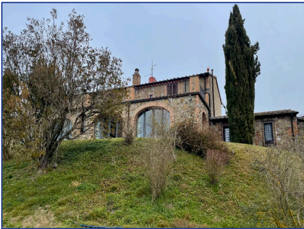
Prospetto posteriore - ovest
