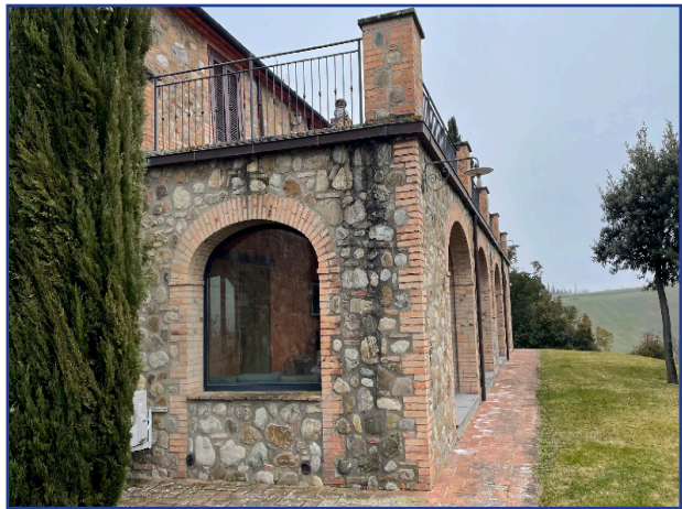
Prospetto posteriore, porticato - ovest
