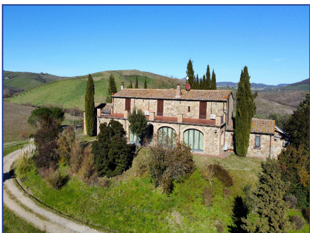
Prospetto posteriore - ovest
