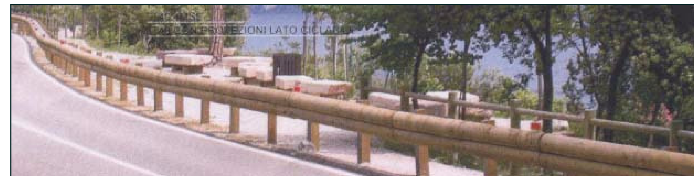
TIPOLOGIA DI GUARDA RAIL IN LEGNO
